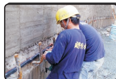
牆面皂土條防漏
