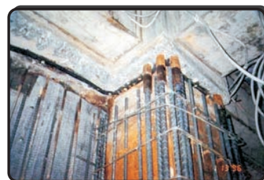
逆打工法層接縫皂土條防漏
