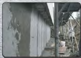
【地下室外牆EP布防水工程】
