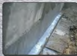
【地下室外牆EP布防水工程】
