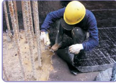
▲ 邊裁剪適當尺寸，熱熔烘烤鋪貼於施工面。
