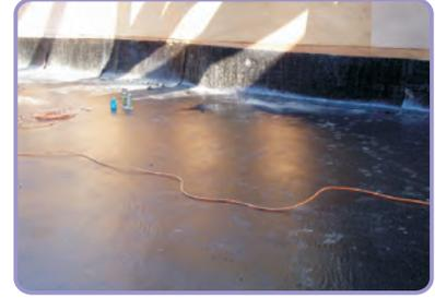
▲ 倒角裁剪適當尺寸立面高度不低於10~15CM與施工面接處封口膠封口。
