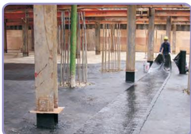
▲施工面須完全乾燥，塗佈滲透型瀝青底塗。
