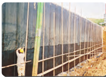
外牆開挖防水修補
