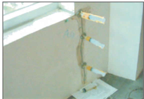
步驟四:低壓灌注示意圖
