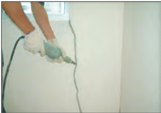
步驟一:裂縫切割示意圖
