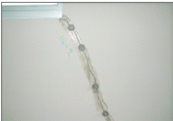
步驟三:針筒底座埋設安裝示意圖
