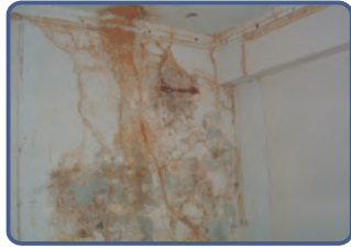
【原有壁癌面】 the original wall cancer
