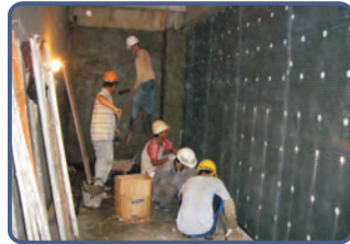
【表面粉刷施作】 surface painting construction
