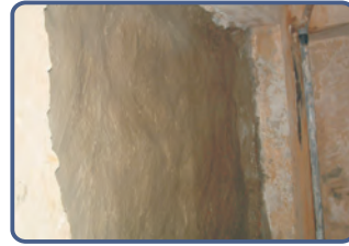
【+1:2防水粉刷】 +1:2 waterproofing painting
