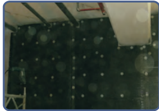
【導水版鋪設面】 drainage sheet laying finish
