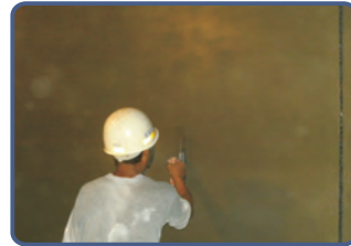
【批刀抹平處理】 trowel flattening treatment
