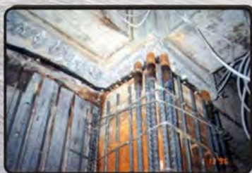
逆打工法二次灌漿縫上下止水
