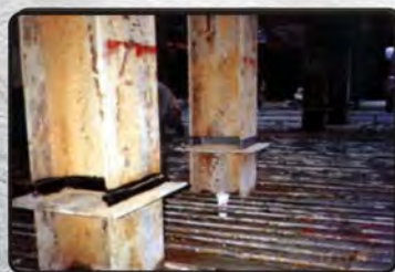
逆打工法二次灌漿縫上下止水
