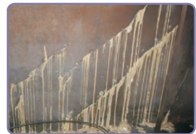
外牆裂縫止漏。
