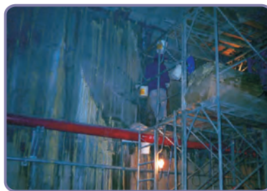
地鐵外牆止漏。
