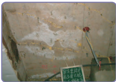
頂版裂縫止漏。
