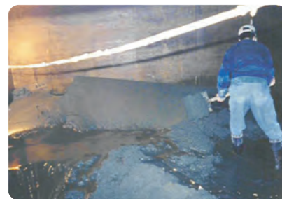
筏基坑湧砂堵漏
