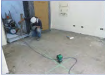
1.施工前確認樓板平整且清理乾淨
