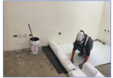
3.鋪設SL-560高性能隔音不織布
