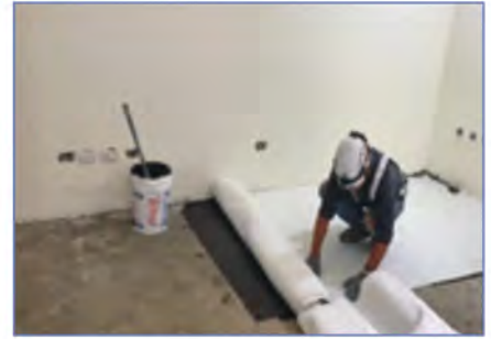
3.鋪設SL-560高性能隔音不織布
