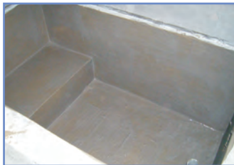
降版浴缸防水
