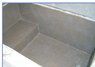
降版浴缸防水
