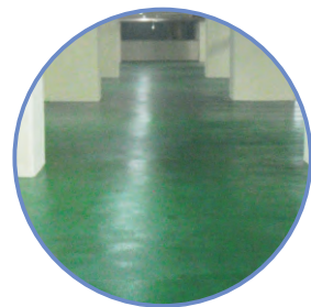
8.完成面(1)(2) Finishing layer
