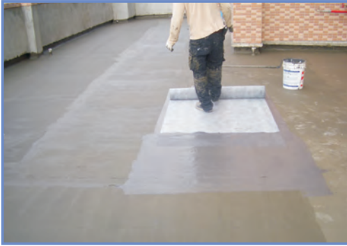
屋頂防水 Roof waterproof
