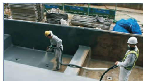
4. 人員施工之情形
