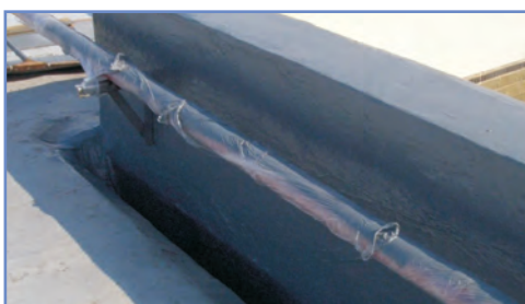
3. 以塑膠膜保包覆保護管線管 路作保護層
